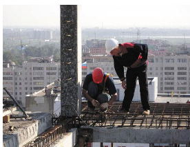
Армирование монолитных конструкций
