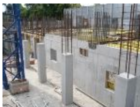
Монолитные железобетонные конструкции здания
