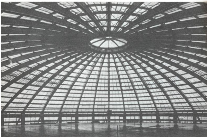
Рис. 17. Большепролетная купольная конструкция из клееных деревянных полуарок
